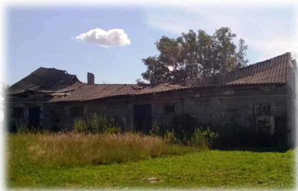
Rysunek 1. Wyroby azbestowo – cementowe: po lewej płyty faliste, po prawej płyty płaskie
